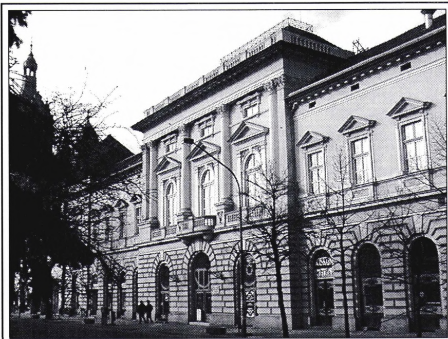
A Móra Ferenc Művelődési Központ közelmúltban felújított épülete
