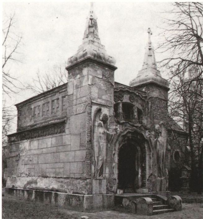
A Balatoni Farkas család sírboltjának főhomlokzata.
